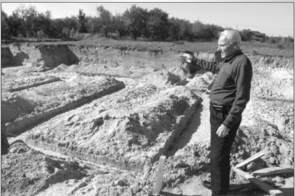
Майбутнє Петропавлівської Борщагівки – діти. Про це повною мірою засвідчило будівництво ще одного дитячого садка на вулиці Парковій, 34, про яке розповідає нашому кореспондентові інженер з будівництва сільської ради Леонід Ремінець
