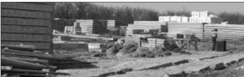
Будівництво дитячого садка на 150 місць ведеться на вулиці Парковій
