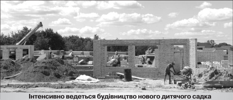
Інтенсивно ведеться будівництво нового дитячого садка
