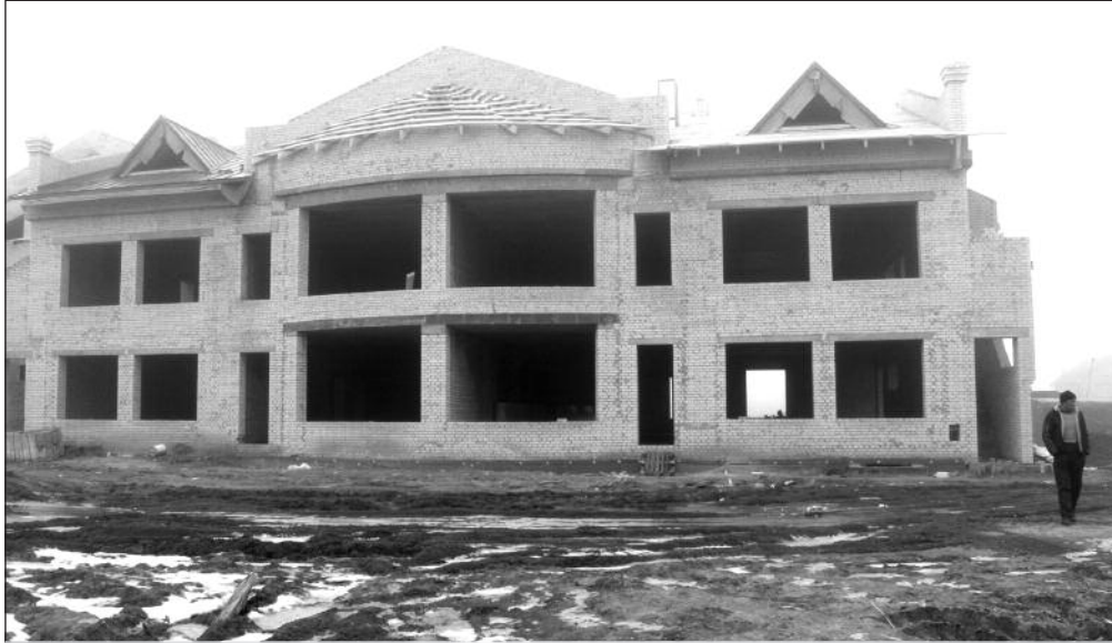
Дитсадок на вулиці Парковій: попереду оздоблювальні роботи
